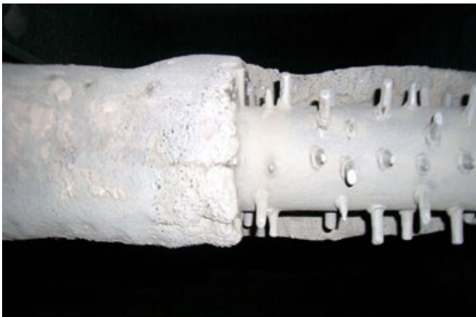
Freilegen schadhafter Bereiche.
