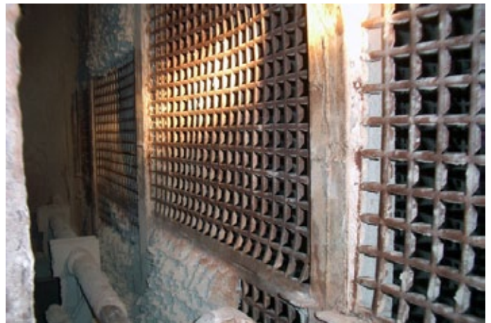
Verdreckter E-Filter mit CO 2 gereinigt – nachher. Bearbeitungszeit: 40 Minuten
