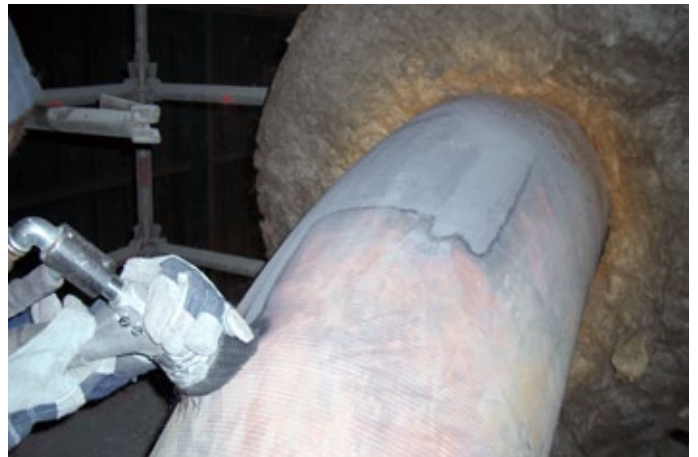
Arbeiten mit DED084 sind auch in Zwangslagen und auf Gerüsten möglich.
