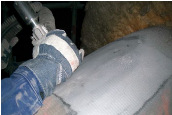
Dieses Bild wurde während des Strahlvorgangs aufgenommen. Nach der Behandlung ist die Materialoberfläche im Ursprungszustand.
