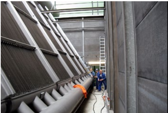
Vorbereitung der Reinigungsfläche.
